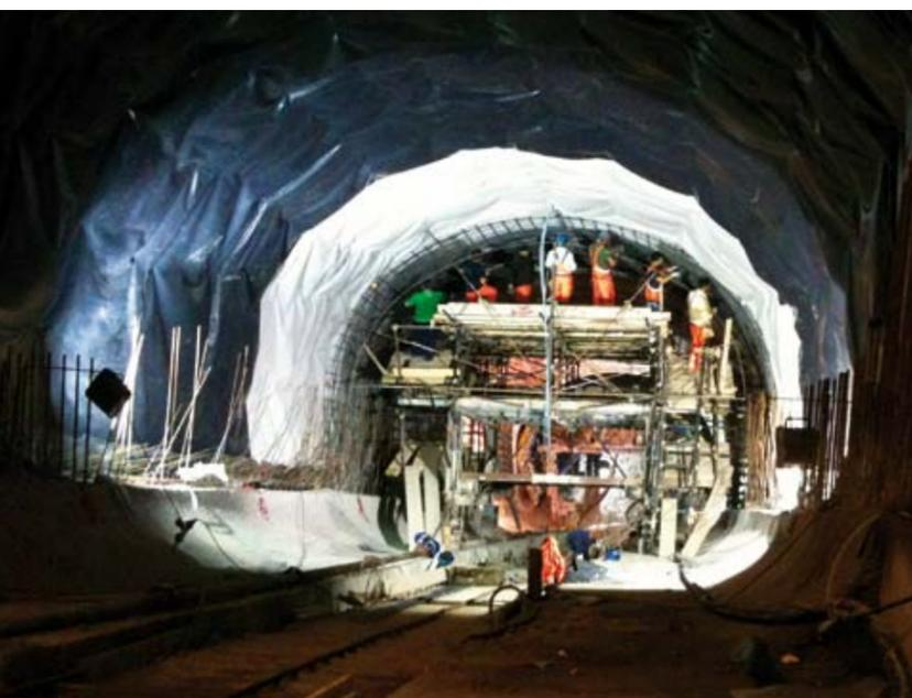
Oltre alle quattro discenderie identiche alle precedenti, abbiamo realizzato anche la discenderia detta "Montecalvario", con sezione di scavo di 59 m<sup>2</sup> e lunghezza di ca. 131 metri, di cui 37 metri con pendenza del 57% ed i rimanenti 94 metri con pendenza del 2,4%.
