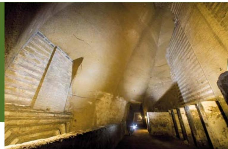
Ponte realizzato per attraversare □ la cisterna; visibile sulla sinistra la spalletta del ponte ancora esistente e a destra i servizi igienici e le sottostanti latrine realizzate durante la II Guerra Mondiale sfruttando proprio l'altezza del ponte; dopo l'attraversamento della cisterna la sezione di scavo prosegue con dimensioni di 4x3 m
