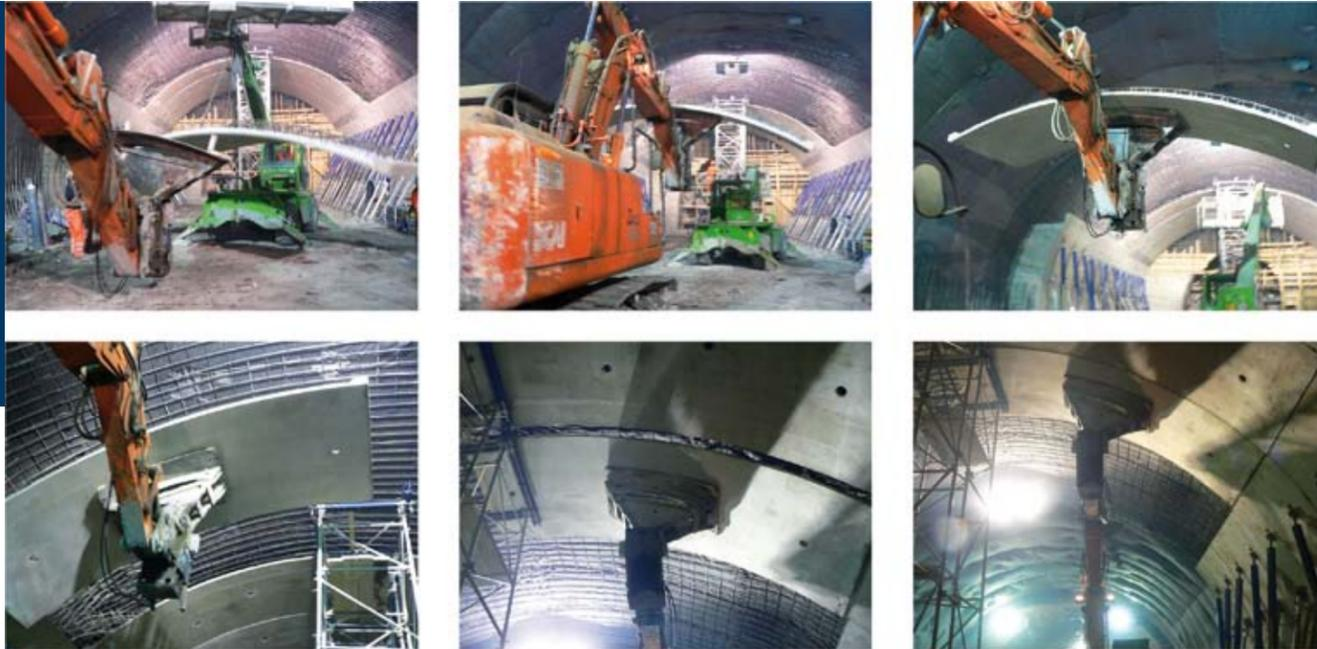
calcestruzzo, a contenimento del getto di calcestruzzo che le ingloba. Le lastre, note come "Predalle curve", hanno l'armatura di progetto già collocata sul loro dorso e per la movimentazione ed il loro posizionamento è stata realizzata una apposita attrezzatura studiata ad hoc.
