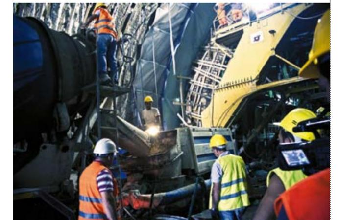
La galleria naturale Sellara misura 704,89 metri di lunghezza per la carreggiata nord e 712,66 metri per la sud, con due by-pass pedonali di sezione di scavo di 18,61 m<sup>2</sup>.
