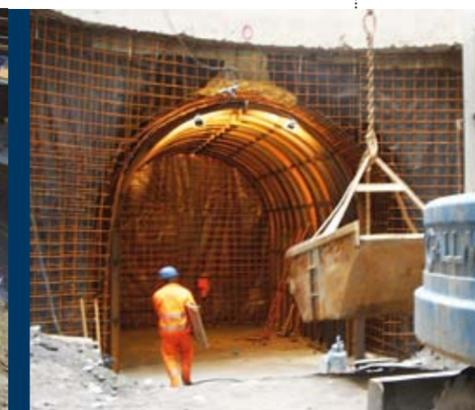
Fase di impermeabilizzazione e armatura sottomuratura □ Scavo pozzo e galleria cieca di alloggio attrezzature per microtunneling □
