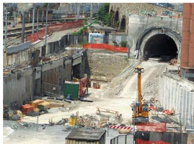
toattraversamento del fascio di binari di stazione Brignole, che doveva essere realizzata senza interruzione e limitazione dell'esercizio ferroviario. Le ragioni della criticità del sottoattraversamento in condizioni di esercizio sono state molteplici, fra le tante ricordiamo le basse coperture, variabili dai 4 ai 7 metri e il materiale inconsistente, principalmente costituito da materiale di riporto.
