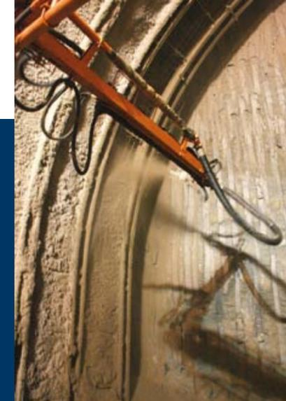
Posa di calcestruzzo proiettato a presa rapida (spritz-beton) con macchinario robotizzato
