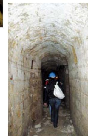
Sezione lunga □ 70 m di 1x2 m rivestita in muratura in attraversamento di una sacca di piroclastiti sciolte
