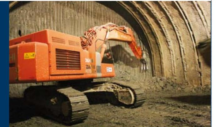
Fase di scavo con escavatore munito di ripper
