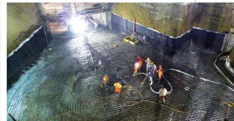
con una sezione troncoconica con un doppio ombrello di infilaggi in calotta, tubi di armatura 139,7 sp. 8 mm a interasse di circa 25 cm, che consentissero di superare tale problematica. Successivamente è stato realizzato il rivestimento di prima fase (centine e spritz), impermeabilizzazione, armatura cassetta e getto del rivestimento definitivo completato poi nel giugno 2006 con il getto di un solettone intermedio che rende la parte superiore della galleria in oggetto pedonabile.
