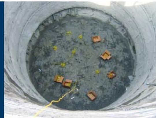
□ Fase di scavo con esplosivo dei pozzi per il viadotto Diaterna
