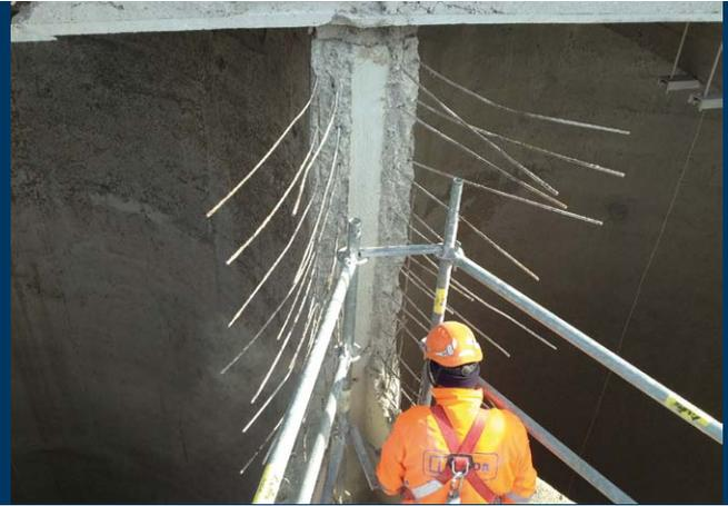
Détail des ferrures de reprise protégées par la démolition manuelle en hauteur et des poutres en porte à faux soutenues par des charpentes provisoires
