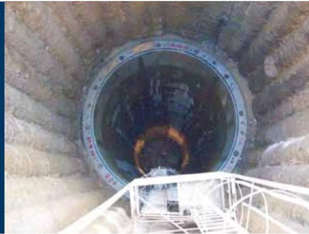
Réalisation de gaine de butée au fond du puits et puits de ventilation
