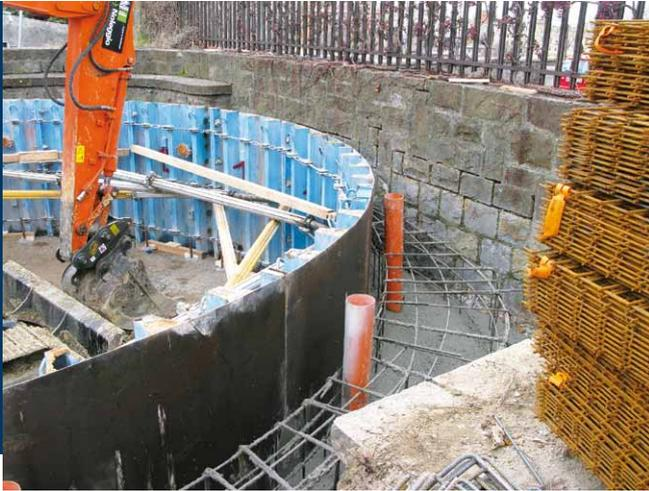
Pose de coffrage circulaire du puits
