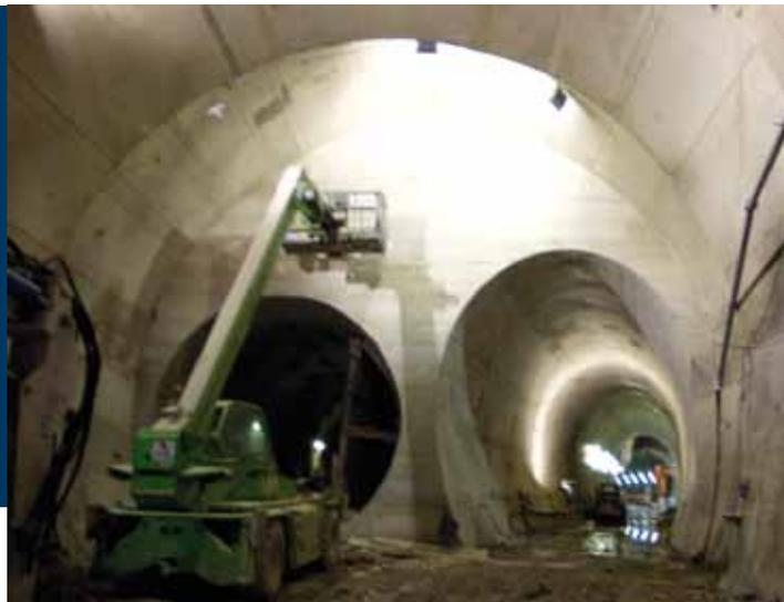
tandis qu'à hauteur du Puits 5.6, l'on a réalisé l'excavation et le revêtement en procédant toujours par demi-section, puis en rabaisant la galerie de raccordement, sur une section d'excavation de 40 m<sup>2</sup> et une longueur de 18 mètres.
