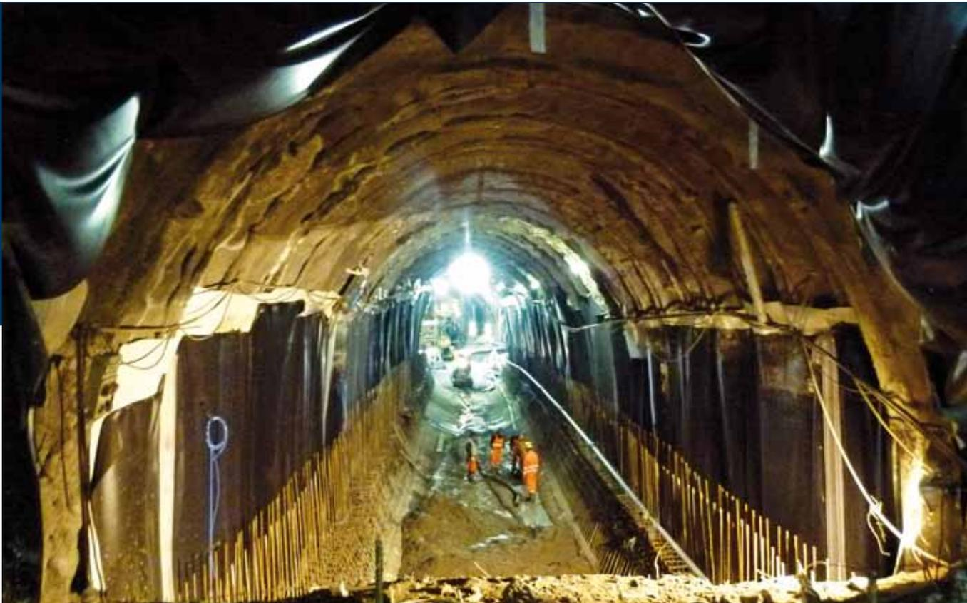
Interconnexion, imperméabilisation et armature de la  deuxième phase
