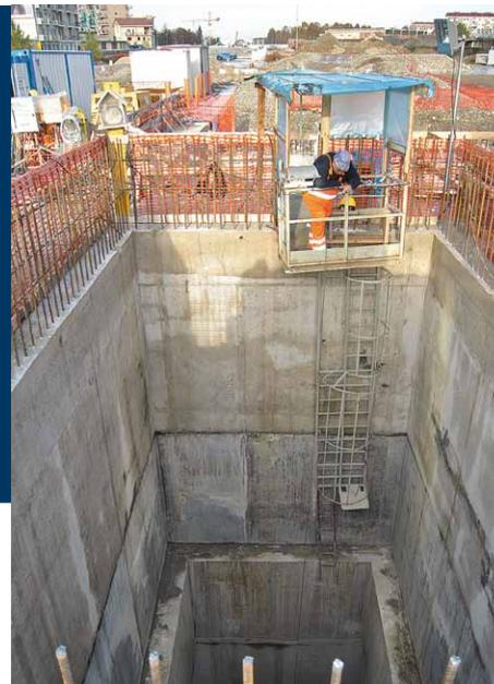
cès à la ligne, dont les numéros de "5" à "9", réalisés en reprise en sous-cœvre, d'un diamètre d'excavation de 6 mètres et d'une profondeur de 11,5 mètres.
