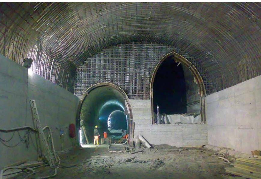
Séquence de montage des prédalles du tunnel de la station
