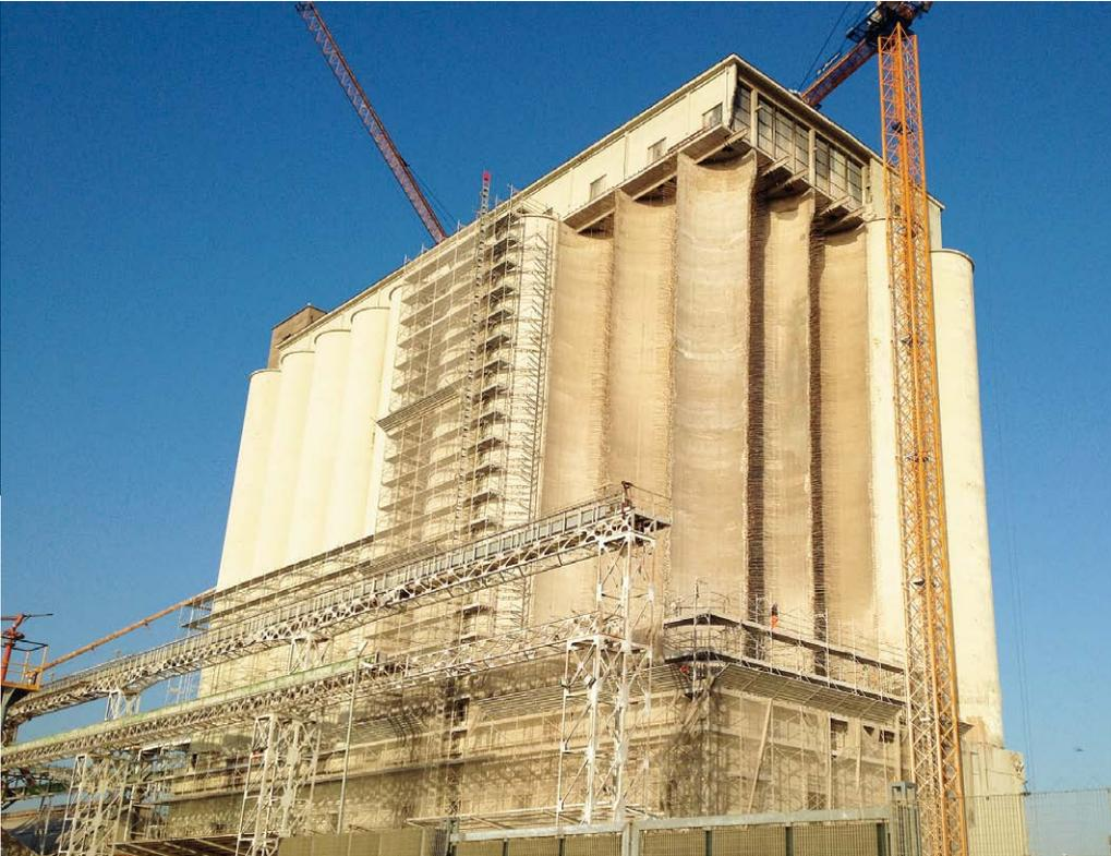
□ Certaines cellules de silo en phase de démolition en hauteur adossées à des silos à démolir sur le petit côté du bâtiment
