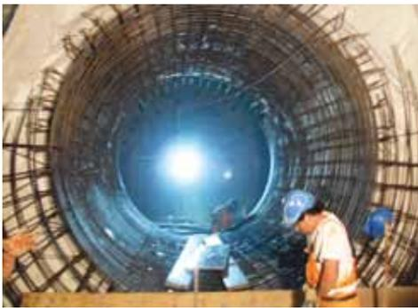
Dix-huit galeries de raccordement aux puits de ventilation ont été creusées sur les tronçons de la ligne incluant l'excavation et le revêtement définitif, après la mise en place des gaines de butée en béton armé au fond des puits pour le renforcement des zones touchées par la démolition. L'excavation a eu lieu en présence de soutènements en béton et chimiques sous la nappe. ■
