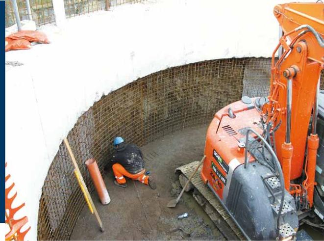
Pose de l'armature pour le voussoir du puits
