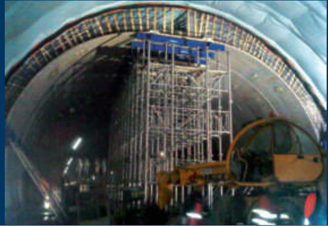
I pozzi strutturali drenanti sono stati realizzati nell'ambito della realizzazione della stazione Poggiolino, eseguendo lo scavo con benna e martello demolitore, rivestimento con rete elettrosaldata e centine metalliche, calcestruzzo proiettato a presa rapida (spritz-beton), armatura e getto calcestruzzo in risalita con casseri rampanti. Con la realizzazione delle perforazioni per i collegamenti idraulici di drenaggio tra i pozzi si sono concluse le nostre lavorazioni.
