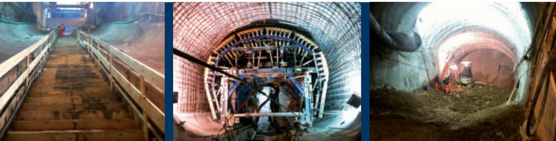
Come nelle precedenti stazioni, anche qui abbiamo realizzato le quattro gallerie di stazione, con le stesse modalità già elencate, anche se per due di esse si è trattato di uno scavo in allargato, con demolizione dei conci posati dall'avvenuto transito della TBM.
