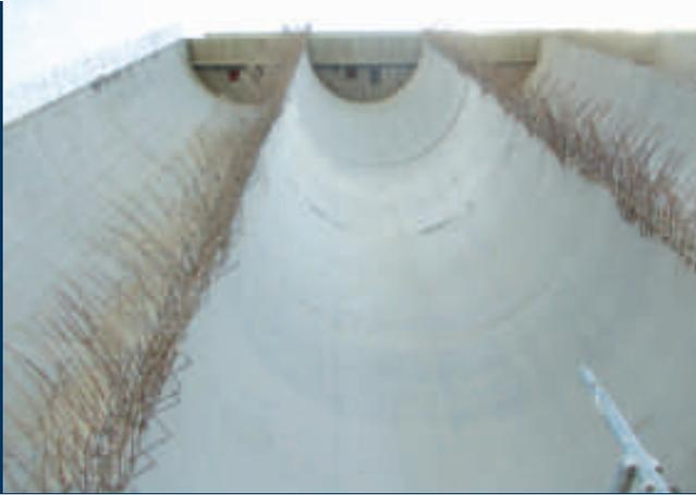
Ferri di ripresa scoperti con demolizione a mano in quota
